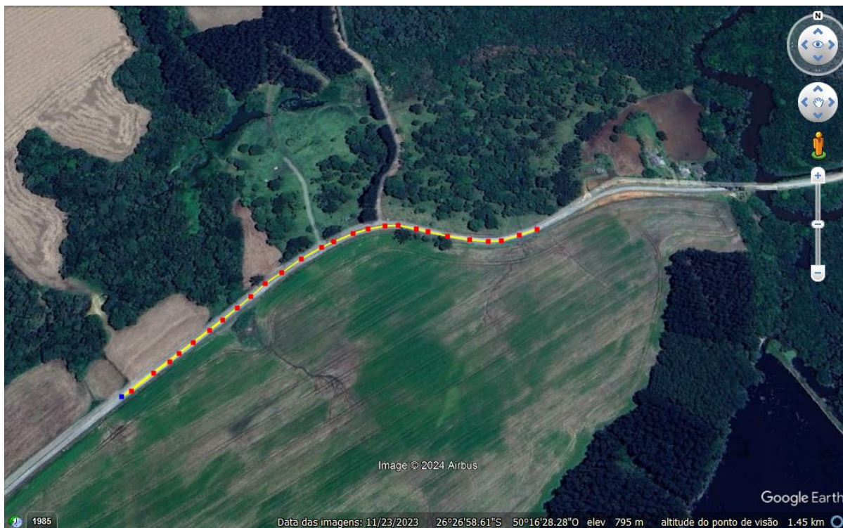
Localização dos 3 trechos - Fonte: Google Earth
