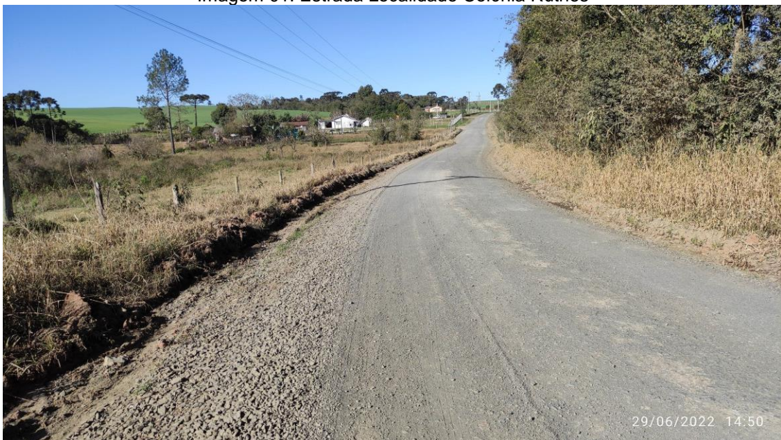
Imagem 01: Estrada Localidade Colônia Ruthes
