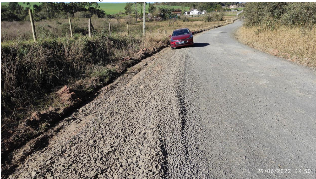
Imagem 02: Estrada Localidade Colônia Ruthes
