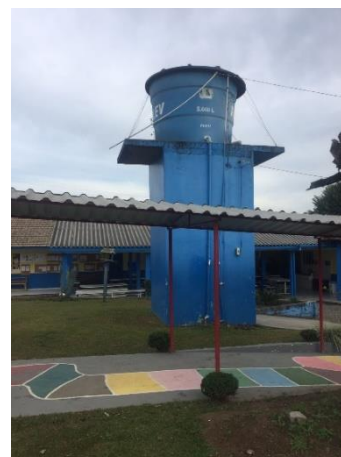
Figura 18: Caixa d'água – Escola Dráusio Celestino da Cunha, Rio Claro.
