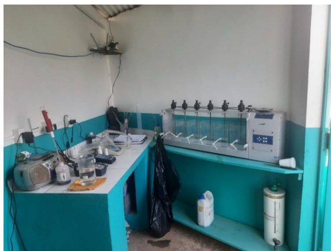
Figura 16: Sala de análises do Controle de Qualidade da ETA dentro da agência
