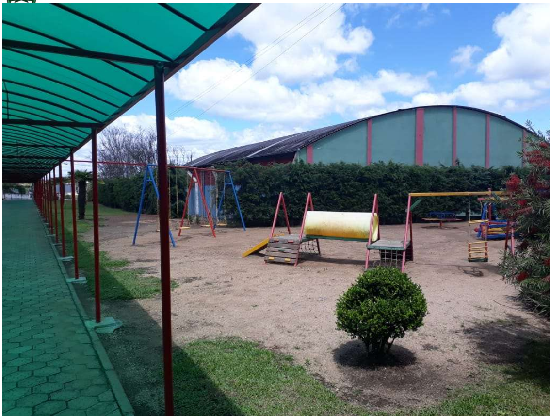
IMAGEM 03 – TERRENO ONDE SERÁ CONSTRUÍDA A NOVA ÁREA DE LAZER
