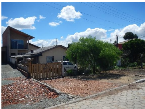
Figura 21. Moradias localizadas abaixo do nível da rua que tornam-se suscetíveis a alagamento (pelo má condução de águas pluviais).
