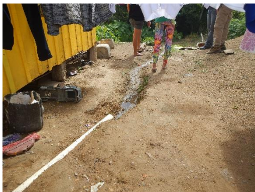
Figura 23. Moradias localizadas abaixo do nível da rua que tornam-se suscetíveis a alagamento (pelo má condução de águas pluviais).
