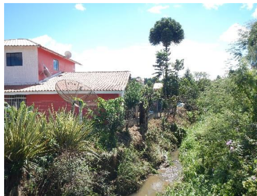
Figura 22. Moradia de alvenaria próxima a margem do rio Major Vieira. Durante o trabalho de campo não foram constatados sinais de movimentação.
