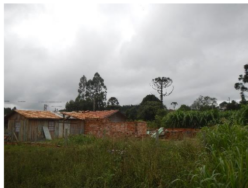
Figura 20. Grupo de moradias próximo ao curso d'água do rio. Moradia em construção foi interditada pela Defesa Civil em caráter preventivo.
