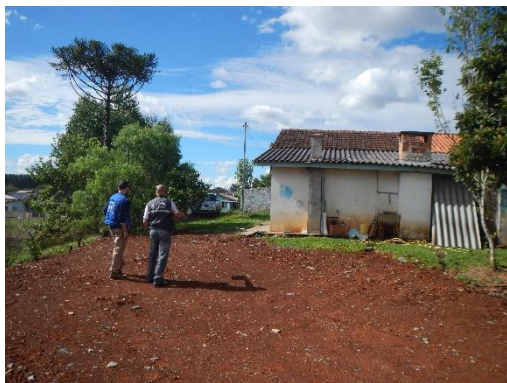
Figura 25. Solo exposto onde o aterro foi realizado, próximo a moradia de alvenaria, antes localizada na crista do terreno.
