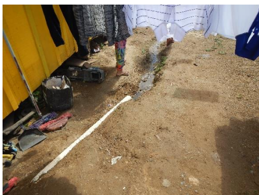
Figura 9. Lançamento de águas servidas (tanque, pia etc.) diretamente no solo, próximo a uma moradia de madeira. O escoamento superficial foi improvisado pelos moradores.
