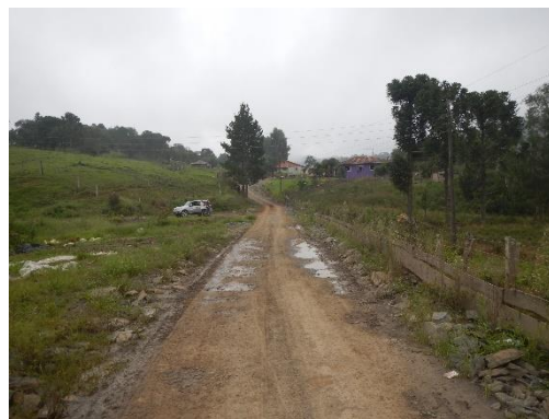
Figura 32. A estrada é inundada, sem atingimento a moradias, cortando o acesso temporariamente.
