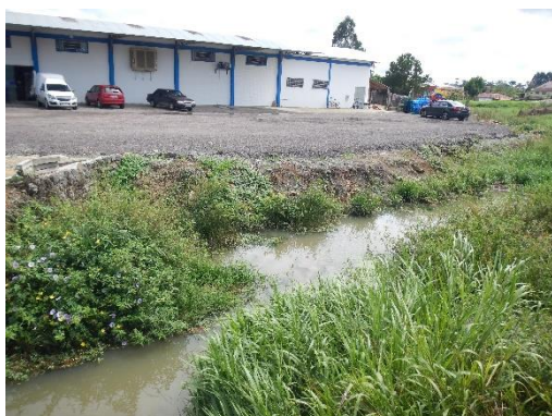
Figura 13. Aterro realizado por comércio local para a execução de estacionamento sobre parte da várzea do rio Major Vieira (Monjolo).
