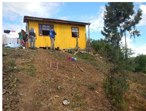
Figura 24. Moradia de alvenaria próxima a margem do rio Major Vieira. Durante o trabalho de campo não foram constatados sinais de movimentação.
