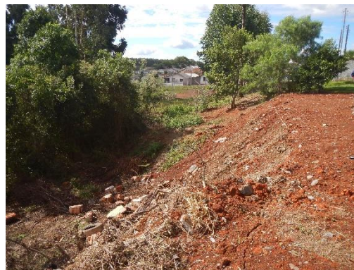
Figura 26. Aterro lançado sobre o antigo terreno, composto de detritos e entulho.
